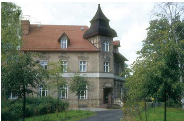
Das Haupthaus vor der Sanierung (Quelle: LIB)
