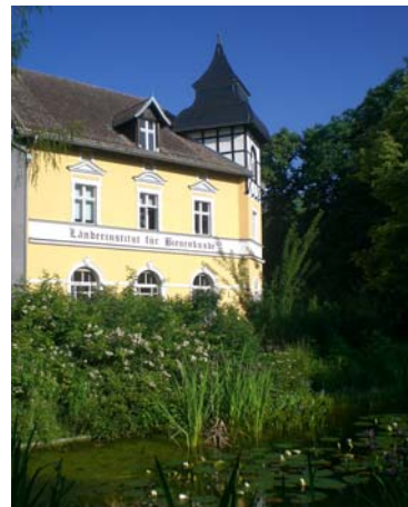
Das Haupthaus nach der Sanierung (Quelle: LIB)
